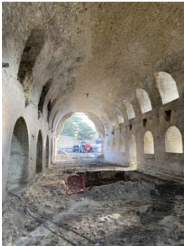
Het interieur van de zuidelijke opslagplaats tijdens de restauratie. In de muren zijn de consoles voor de houten tussenvloer bewaard. Ze worden door een betonplaat vervangen. Ontdaan van hun verdieping krijgt het geheel piraneske allures.
